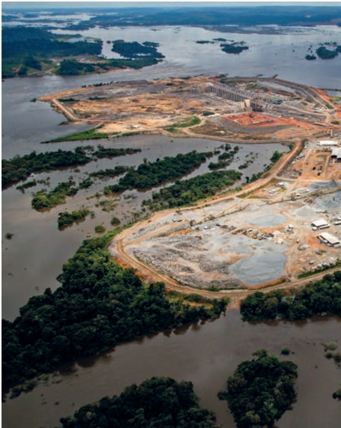
Barragem e desvio do rio Xingu na obra da usina hidrelétrica Belo Monte, Altamira (PA).
