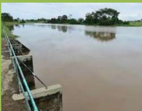
Foto 52 - Reservatório e barragem em local da captação do igarapé Redenção (DEPASA), em Bujari.
