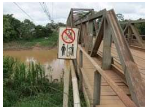
Foto 15 - Ponte sobre o rio Acre Epitaciolândia e Brasiléia.
