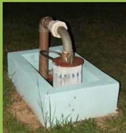
Foto 136 - Poço tubular (Aquífero Solimões/ Cruzeiro do Sul) - DEPASA, em Mâncio Lima.
