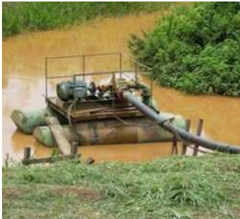
Foto 10 - Captação no Igarapé São Pedro (DEPASA), em Assis Brasil.
