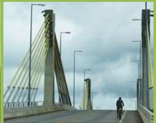
Foto 110 - Ponte sobre o rio Tarauacá (BR-364), em Tarauacá.
