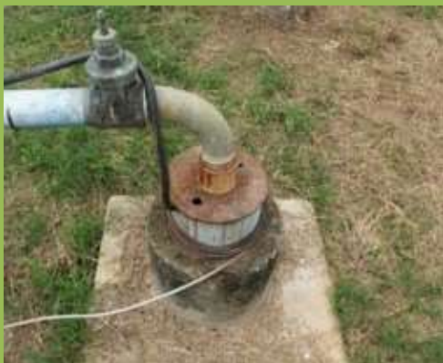
Foto 108 - Poço tubular (aquífero Solimões) - DEPASA, em Tarauacá.
