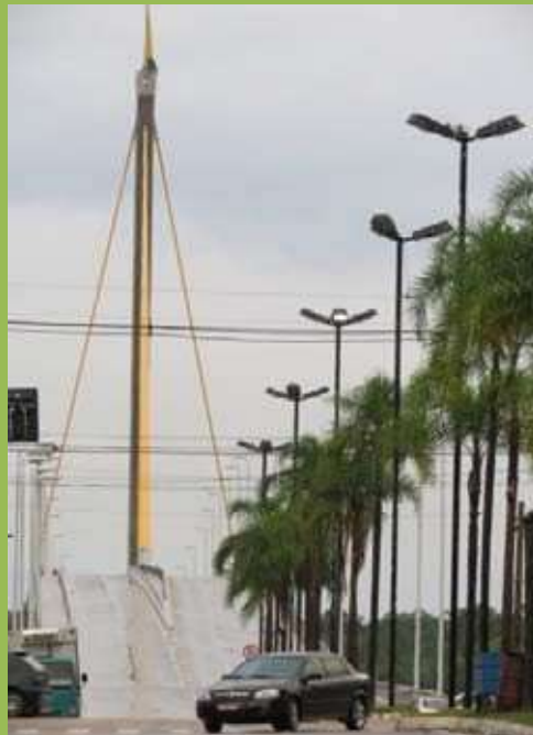
Foto 142 - Ponte sobre o rio Juruá, em Cruzeiro do Sul.
