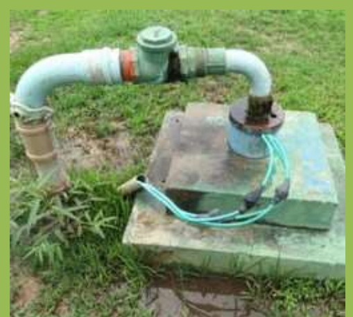
Foto 137 - Poço tubular (Aquífero Solimões/ Cruzeiro do Sul) - DEPASA, em Cruzeiro do Sul.
