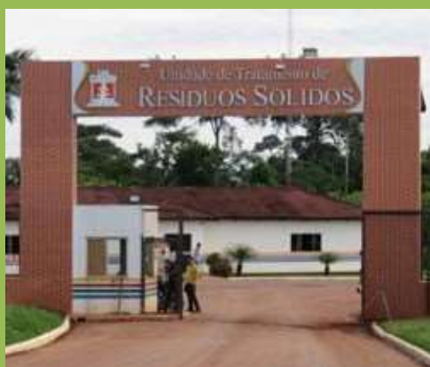
Foto 77 - Entrada da UTRE.
